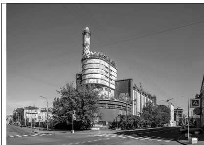
Рис. 5. Силовая станция фабрики "Красное знамя"
