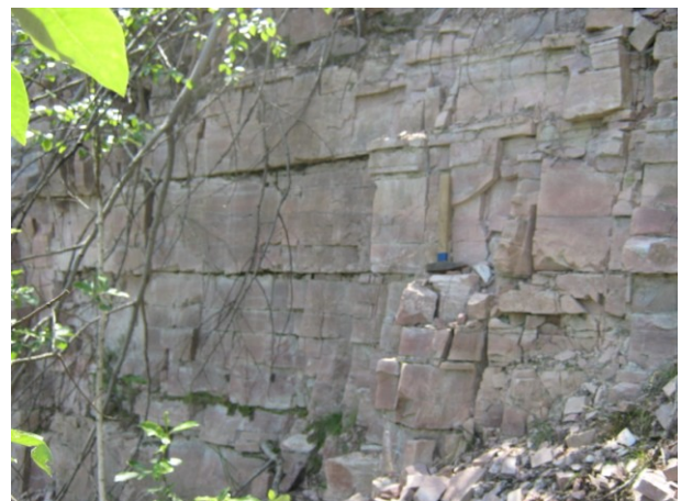
Рис. 4. Характер трещиноватости кварцитов
