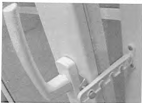
Рис. 11. Микропроветривание через приоткрытую створку
