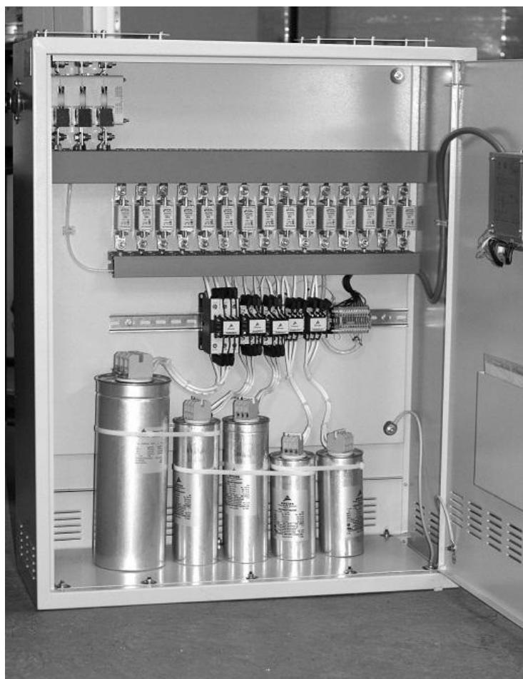
Рисунок 4.1. Компенсатор реактивной мощности с конденсаторными батареями
