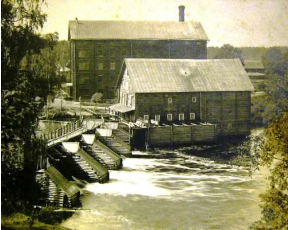
Рис. 3. Предприятия на водяных мельницах у плотины Новгородского шлюза. Вид с севера, с верхнего яруса завода Лотонина. Рубленая плотина переделана на 4-х пролётную – около 1890г. Редкое фото – около 1900 г.
