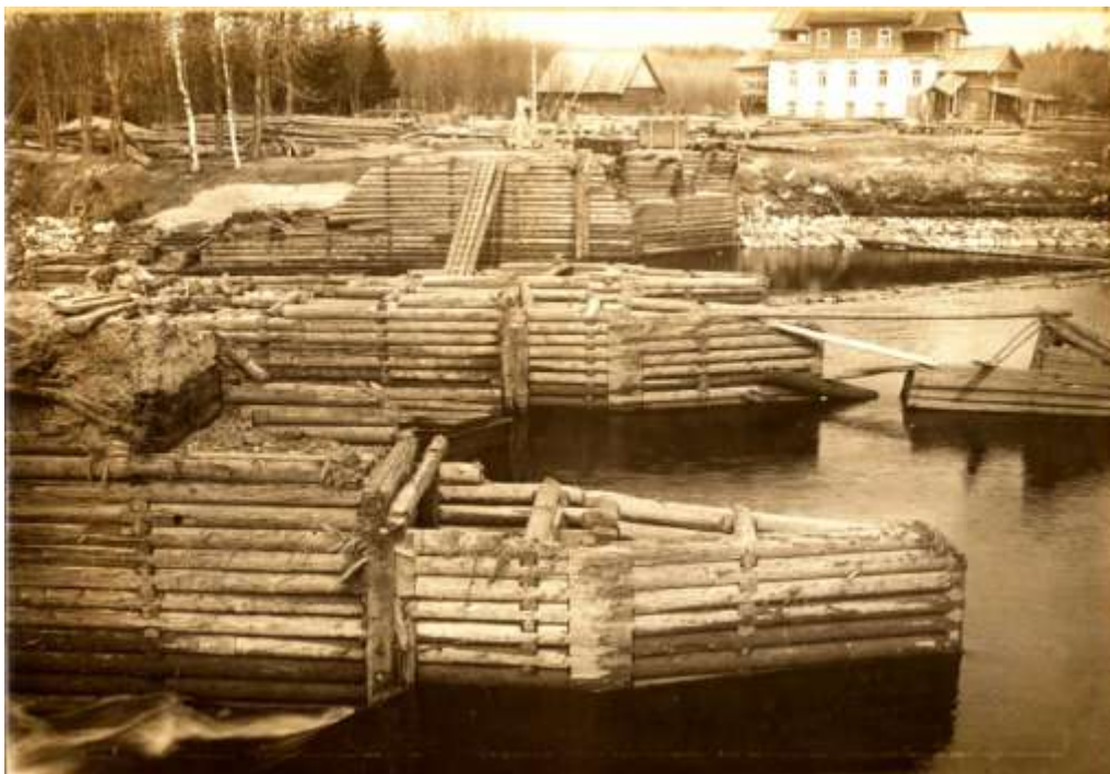
Рис. 4. Тихвин. Плотина и большой каменный дом на Новгородском шлюзе. Вид аварийных повреждений после ледохода 1926. Вид с юга, с левого берега (Альбом комиссии 1926)
