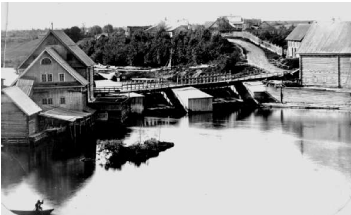
Рис. 2. Восточная окраина Тихвина - Новгородский шлюз, завод Лотонина (слева) и деревня Пещёрка (на дальнем плане). Вид с северо-запада, с высокого правого берега реки. Редкое фото из альбома 1865г. (ЦГА КФФД, № 352, А-6112, иссл. Е.В.)
