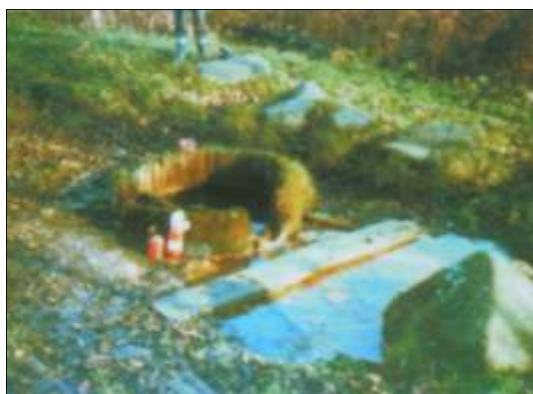
Рис.4. Деревянный каптаж железистого источника «Девять изб»
